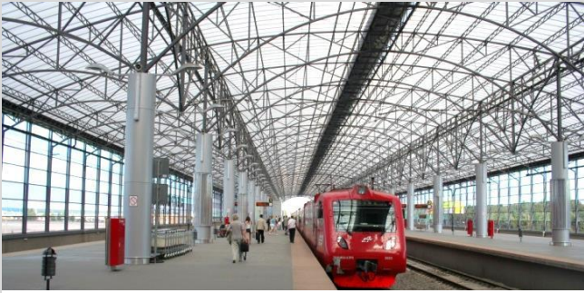
Кровля вокзала аэроэкспресса Шереметьево
