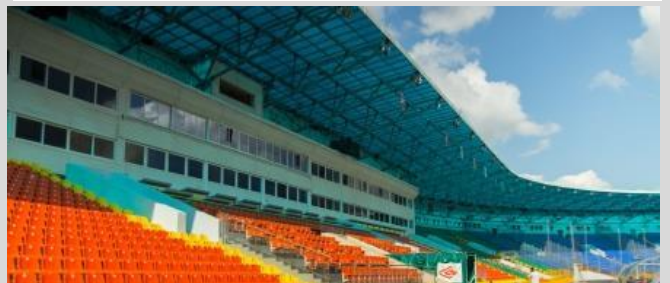
Кровля футбольного стадиона, г. Казань
